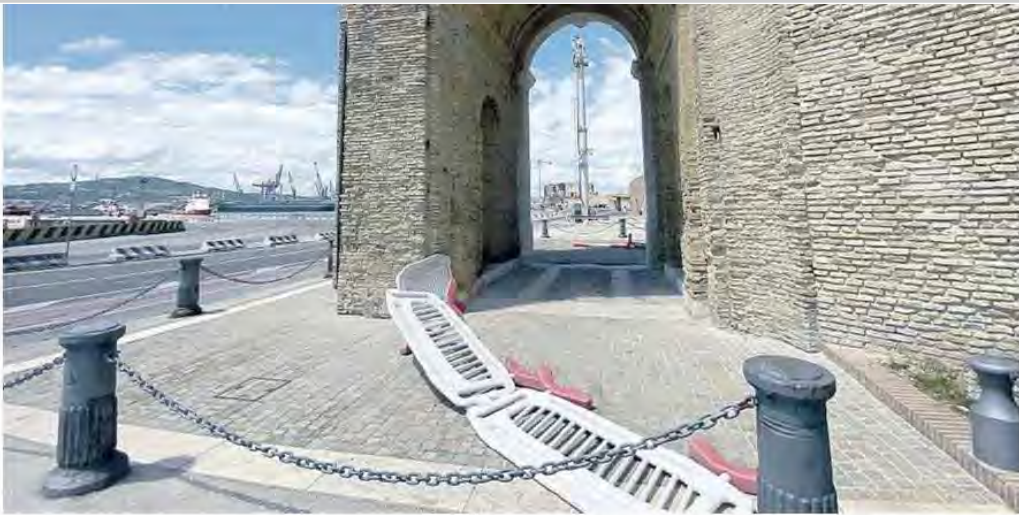
Le transenne di protezione dell'arco Clementino divelte e abbandonate a terra
